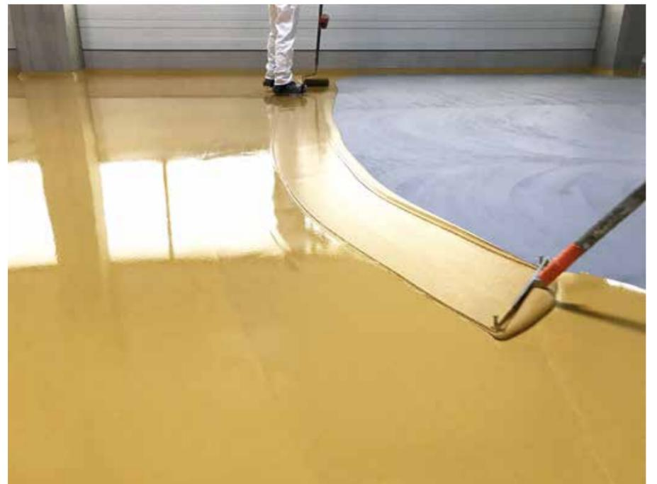
Aufziehen der Beschichtung Crete SL 80 im Farbton beige. Einmaliges Nacharbeiten mit Entlüftungswalze. Der Untergrund wurde mit der Kratzspachtelung Crete TF 60 in grau versehen.
