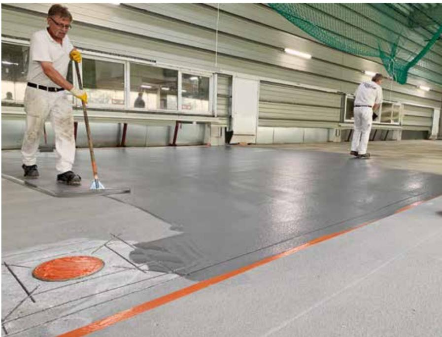
Grundierung Crete TF 60 (Farbton grau) und leichte Absandung mit Quarz 03/078 DF. Der Betonuntergrund wurde kugelgestrahlt mit den notwendigen Verankerungsschnitten.
